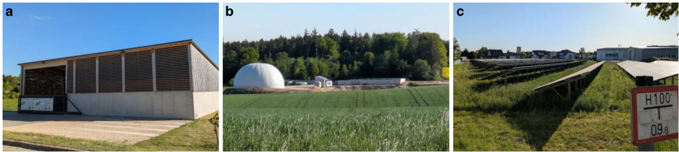
Abb. 5 Infrastrukturen der Energiewende auf dem fränkischen Jura. a Hackschnitzelspeicher eines Nahwärmenetzes; b Bau einer Biogasanlage; c Freiflächenphotovoltaik. (Bilder: S. Fina)
