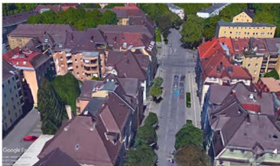
(b) Blickrichtung Rosenaustraße, NW
